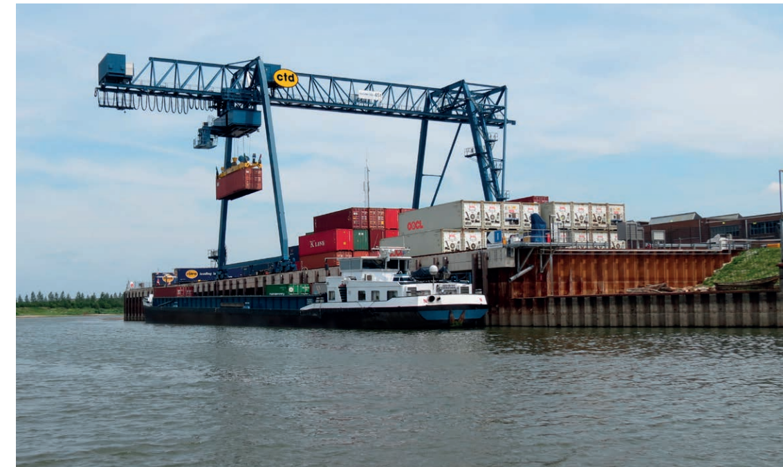
Containerterminal Doesburg: een initiatief van logistiek dienstverlener Koninklijke Rotra. Op de hoek van de kade is een LNG-installatie te zien.
