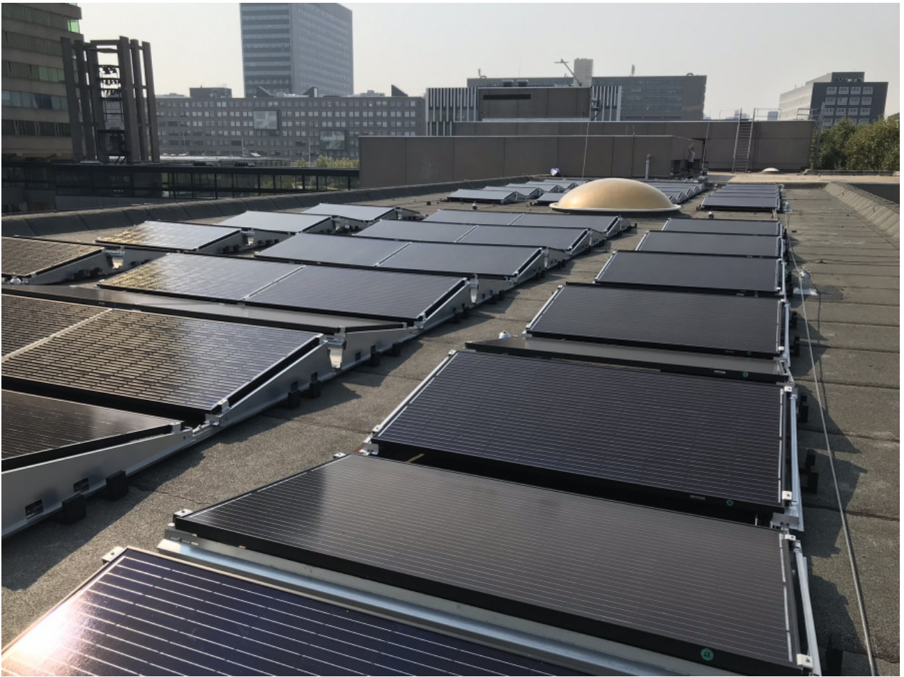
Er zijn zonnepanelen geplaatst op het dak van het Erasmus Building en Van der Goot Building.
