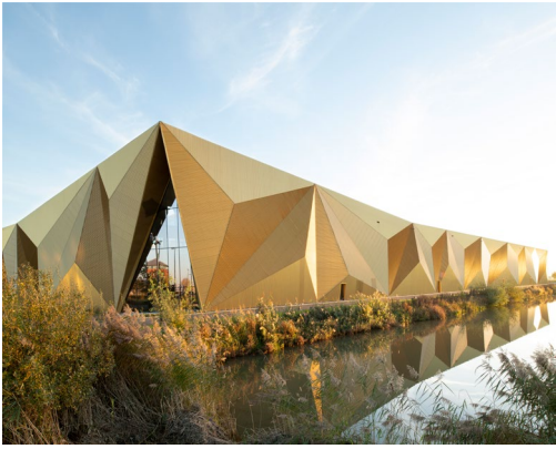
Nationale Munt, Houten refurbishing en eind-montage van printers uit internationale onderdelen
