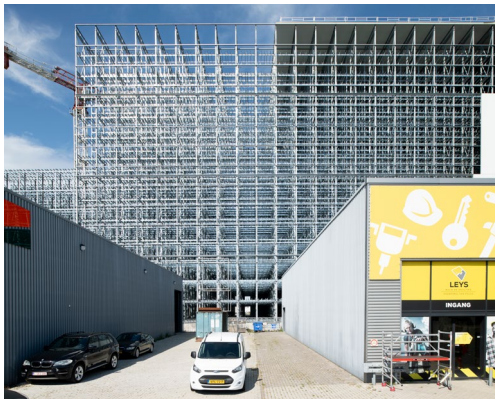
Agristo, Tilburg geautomatiseerd highbay friet-koelhuis in aanbouw, met racks als draagstructuur
