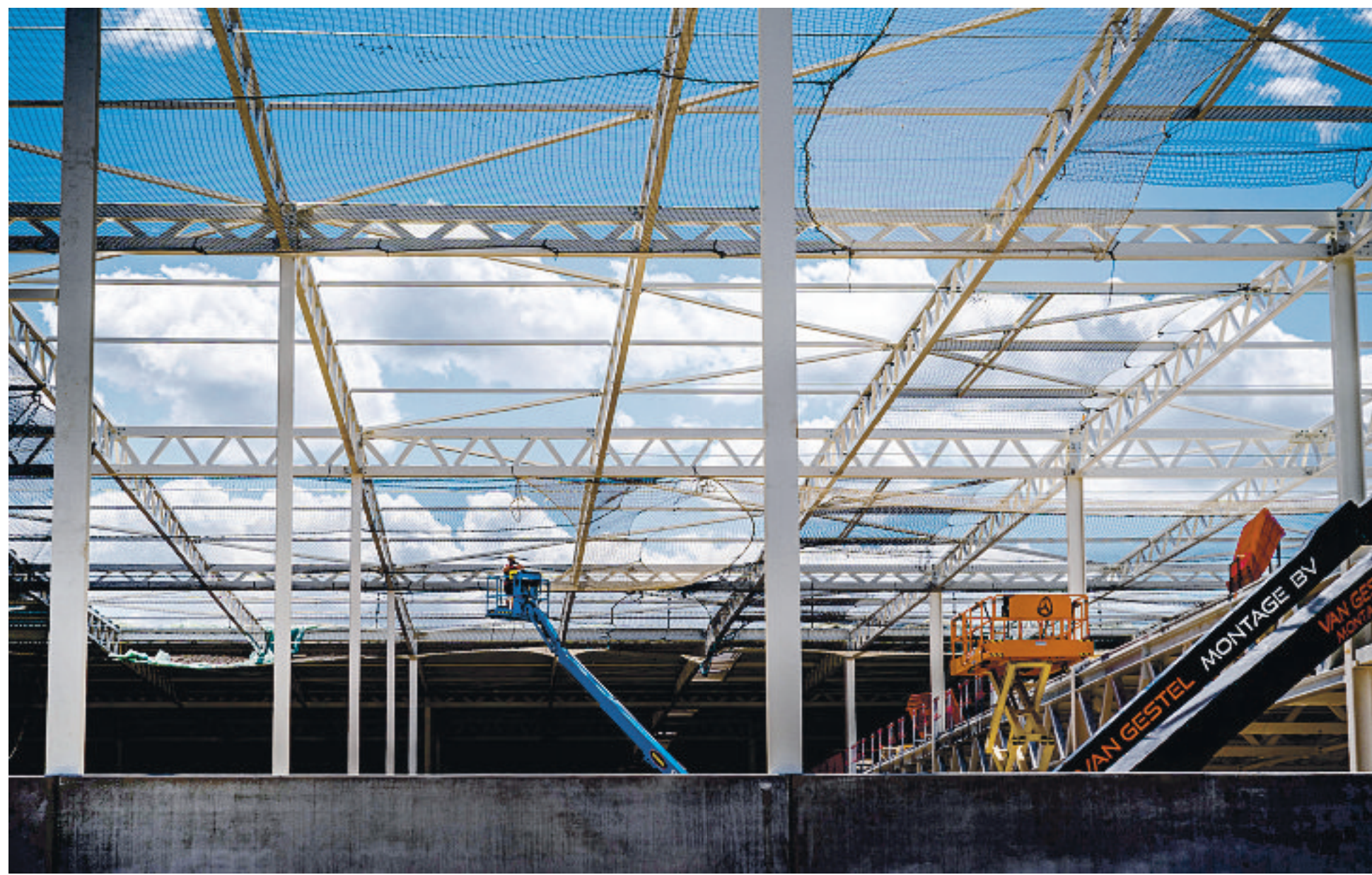
In Waalwijk wordt een nieuw distributiecentrum gebouwd. Het kabinet wil zulke investeringen de komende twee jaar bevorderen met een belastingkorting.
